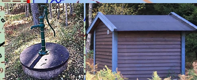
MANUELL PUMP SAMT PUMPHUS TJÄNLIGT VATTEN
